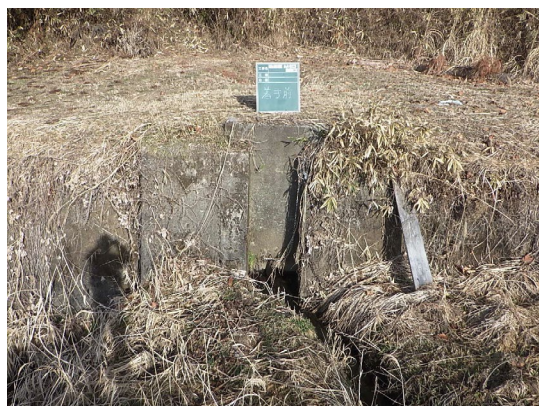
かんがい排水工事（東納庫） (着手前)
