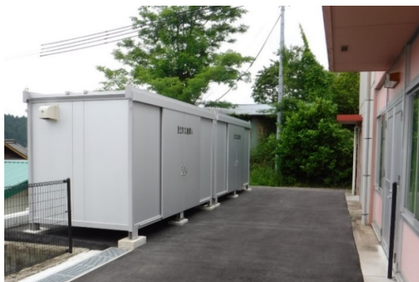
防災倉庫設置工事（旧役場庁舎敷地内）
