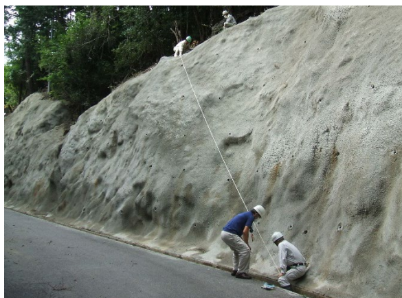
林道田内野平線 改良状況
