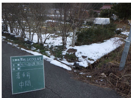
かんがい排水工事（津具） (着手前)
