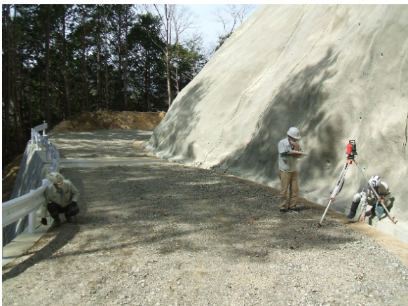
林道笹頭山線 開設状況
