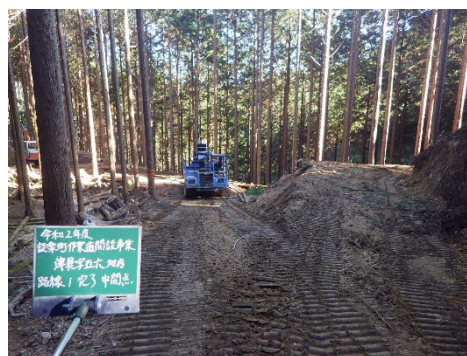
現場写真（作業道開設後：五六①線）
