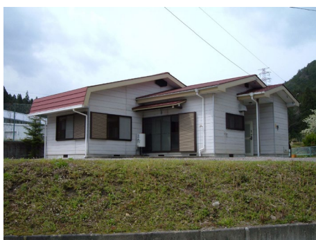
屋根及び外壁改修（全景）
