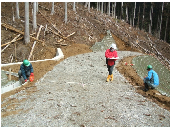
林道白樺支線 開設状況
