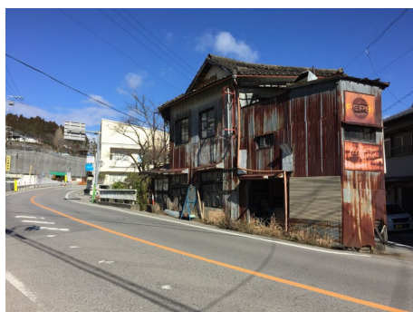
危険空家（解体前）
