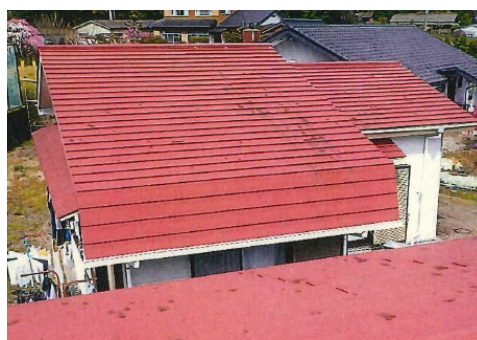
屋根及び外壁改修（屋根）
