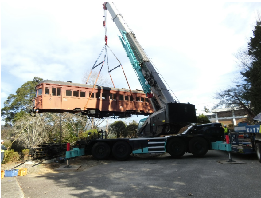
田口線車両移送作業の様子（旧郷土館敷地内）
